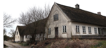
Gavl på det eksisterende stuehus
